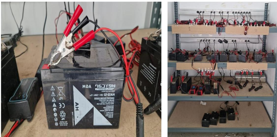
**Figura 11.** Sala habilitada para la carga simultánea de hasta 60 baterías.
